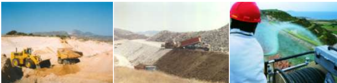
Ανάπλαση, Χωματοκάλυψη και υδροσπορά με fiber wood
