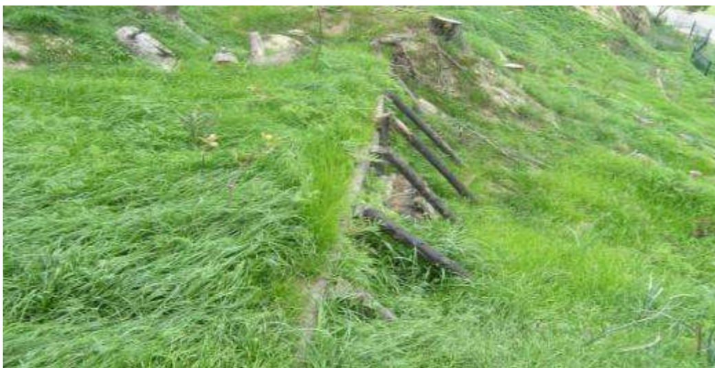
Εικόνα 3 -3: Σπορά ταχέως αναπτυσσόμενης βλάστησης πάνω από γεμάτο με έδαφος, κορμόφραγμα με την τεχνική της υδροσποράς.
