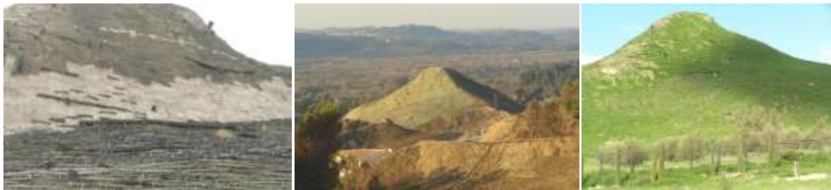
Επικάλυψη με γεώφασμα και υδροσπορά στον Κρόνιο Λόφο
