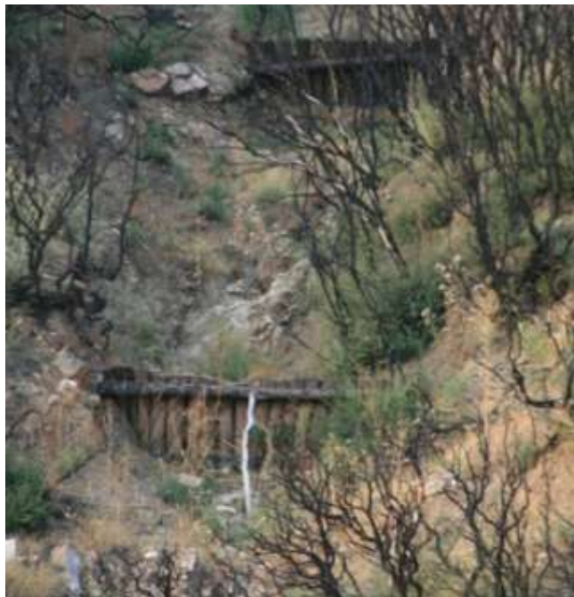
Εικόνα 2 - 17: Κατασκευή Κορμοφραγμάτων
