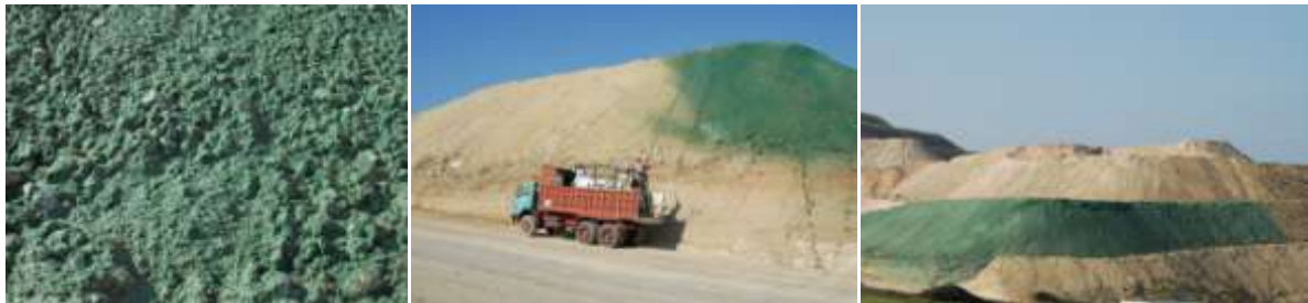
Υδροσπορά με κάλυψη fiber wood
