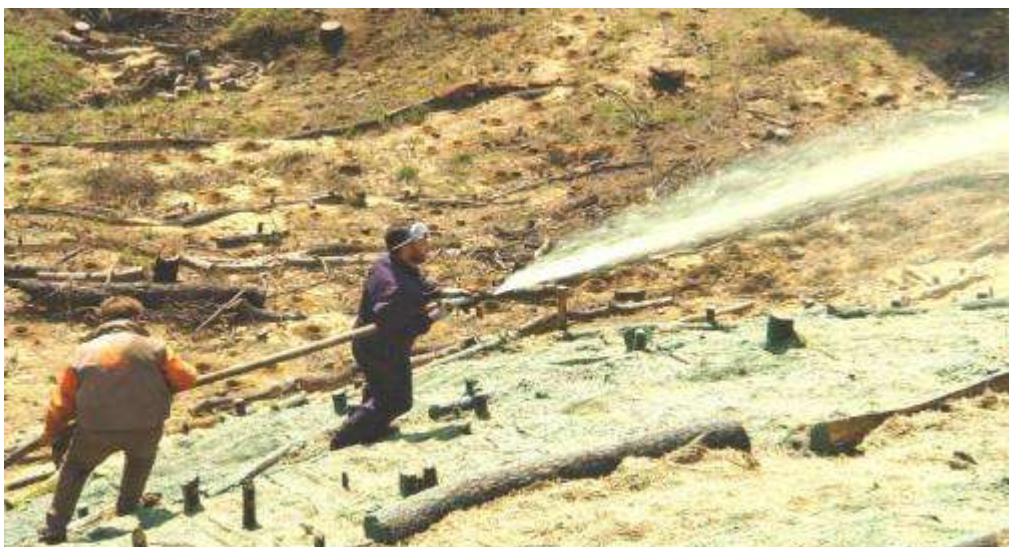
Εικόνα 3 - 4: Υδροσπορά επιφανειών με μεγάλη κλίση.
