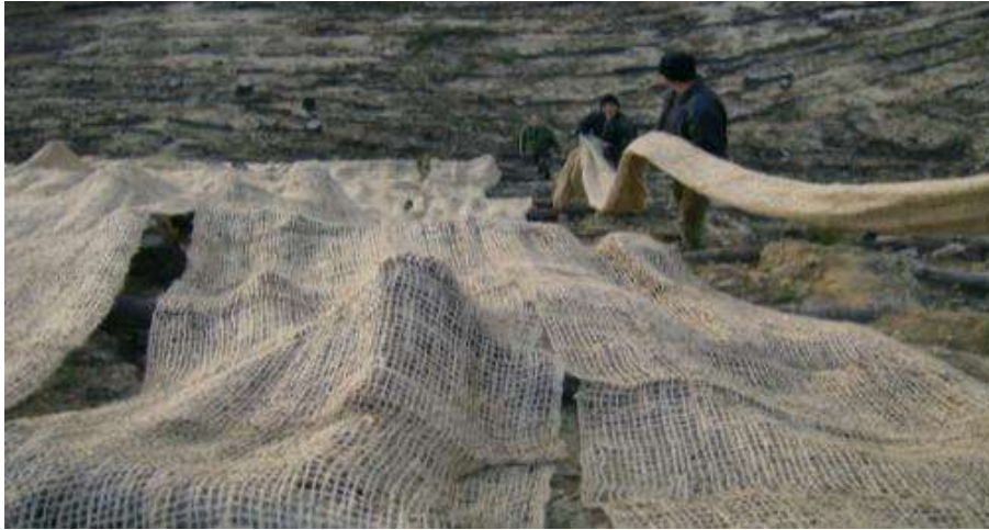
Εικόνα 3 - 5: Τοποθέτηση γεφυρώματος σε επικλινείς θέσεις.
