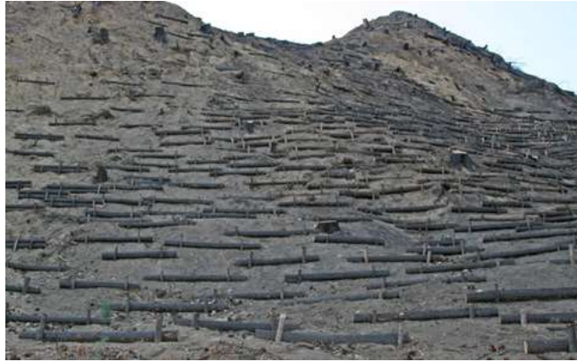
Εικόνα 2 - 15: Ο έλεγχος της διάβρωσης των εδαφών και των πλημμυρικών φαινομένων με την κατασκευή κλαδοπλεγμάτων και κορμοπλεγμάτων.
