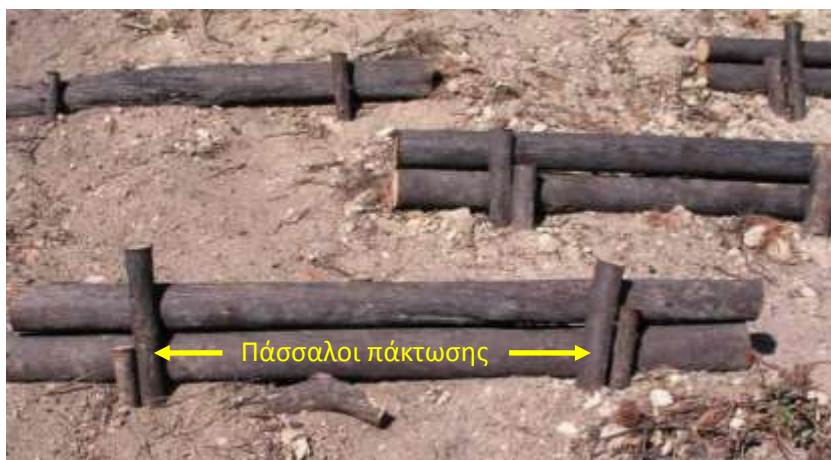
Εικόνα 3 - 1: Κορμοδέματα σε καμένη δασική έκταση.
