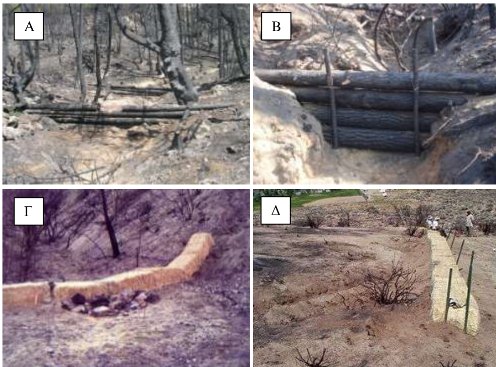
Εικόνα 3. Φράγματα από καμένους κορμούς στο ελατοδάσος της Πάρνηθας (Α) και πεύκης στον Ταύγετο (Β) και από μπάλες με άχυρο σε ανώτερο τμήμα (Γ) και στην πεδινή περιοχή (Δ) ενός υδατορεύματος στην Αμερική.
