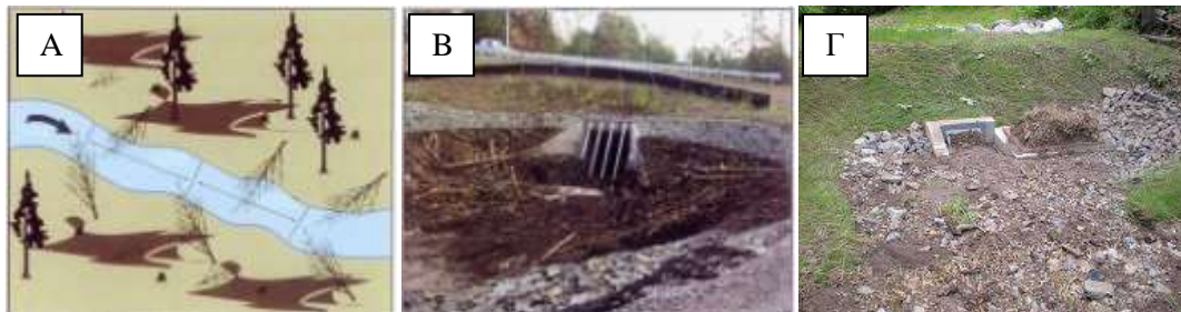
Εικόνα 4. Υλοτομία και ρίψη στην κοίτη καμένων δένδρων λοξά και αντίθετα της ροής (Α), δεξαμενή στην κοίτη υδατορεύματος για την συγκράτηση υπολειμμάτων καμένων δένδρων (Β) και κακώς συντηρημένη δεξαμενή συγκράτησης φερτών υλικών (Γ).
