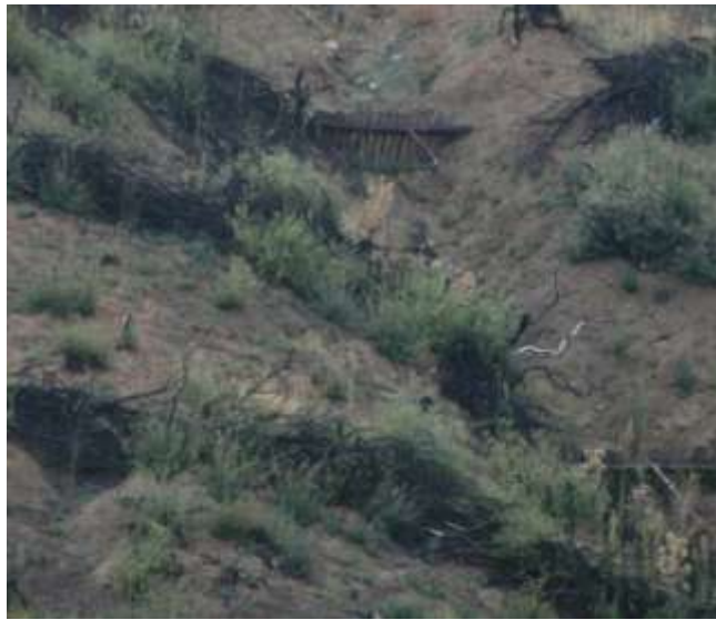
Εικόνα 2 - 16: Έλεγχος της διάβρωσης με την κατασκευή κλαδοπλεγμάτων & κορμοπλεγμάτων.
